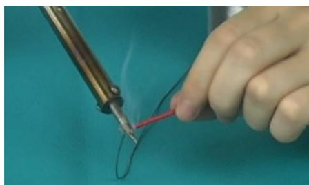
图 3-10 用电烙铁给线芯两端搪锡
