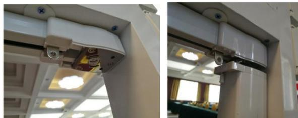
图 5-53 窗帘电机及轨道安装图
