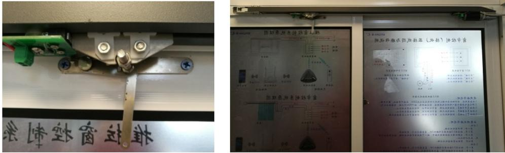
图 5-48 推拉窗推窗机安装图
