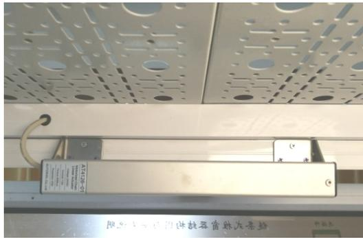
图 5-41 电动下悬窗链条式推窗机安装效果图
