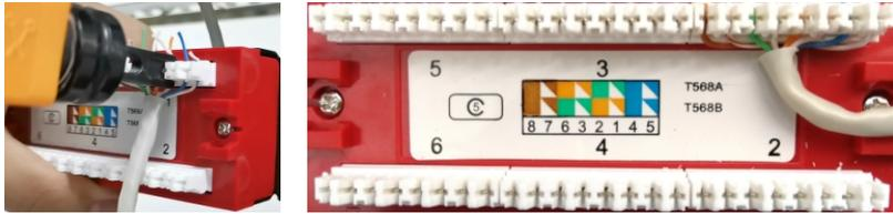
图 3-54 端接网络配线架模块
