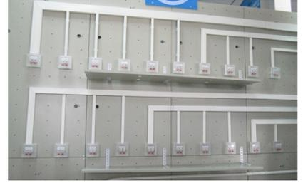
图 5-17 网络插座的安装
