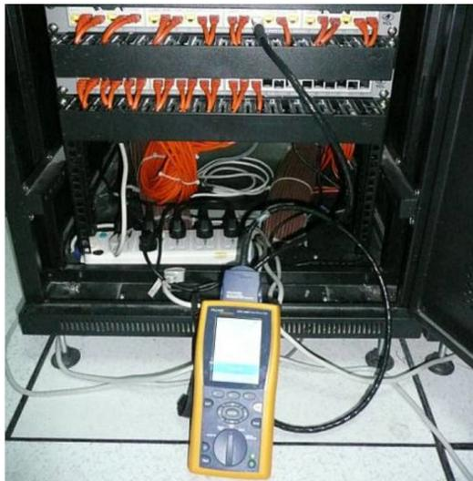
图11-32 主机端端接状态
