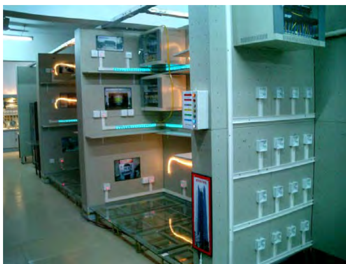
北京工业职业技术学院网络综合布线实训室-局部(西元展示装置)
